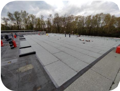
Neue Dachpappe für das Dach der Bootshallen
